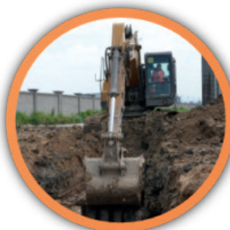
WYKOPY FUNDAMENTOWE
